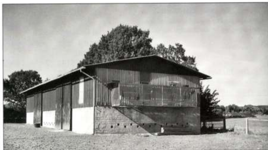
Die etwa 160 m 2 große Halle auf dem ehemals landwirtschaftlich genutzten Anwesen der Familie dient heute als Pferdestall, zur Unterstellung einiger Geräte und Maschinen und sie beherbergt an der Südseite den Taubenbestand von Hermann Berling.
